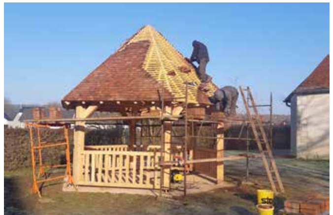
Construction du kiosque
